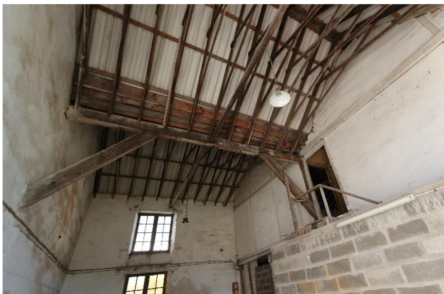
Figure 13 : Structure bois de la charpente pouvant accueillir les chauves-souris – Entrée bâtiment Ouest (juin 2022)
