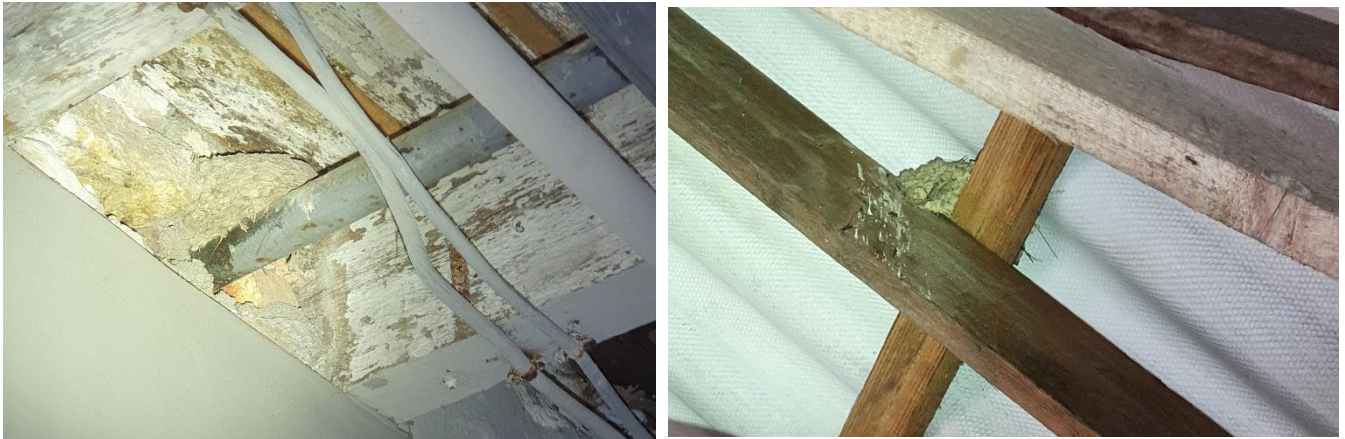
Figure 11 : Nids d’Hirondelles rustiques au sein du bâtiment (rez-de-chaussée à gauche, étage à droite, 2021-2022)
