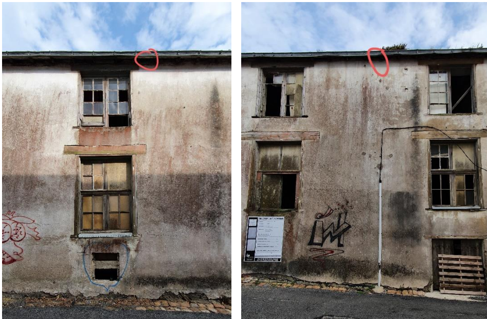
Figure 8 : Localisation des nids occupés par les couples de Martinets sur la façade ouest, rue Dixmude (juin 2022)
